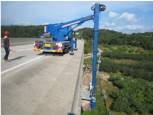
교량점검차를 이용한 근접조사
