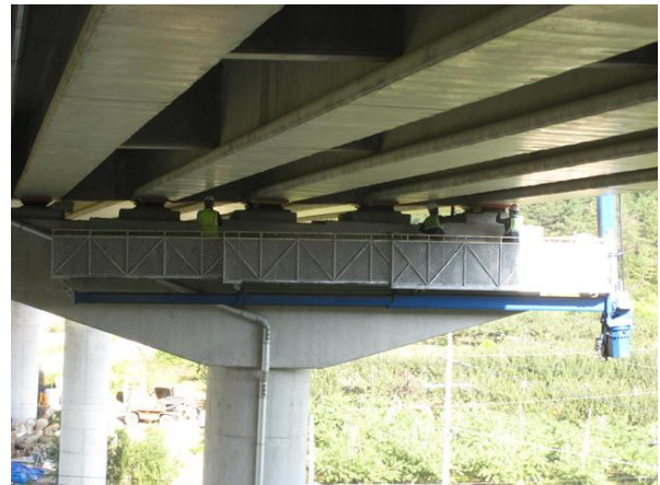
교량점검차를 이용한 근접조사
